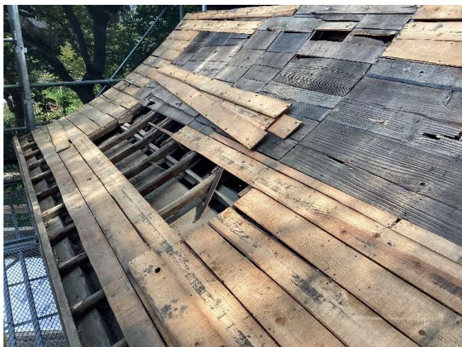
屋根瓦を外した状況
