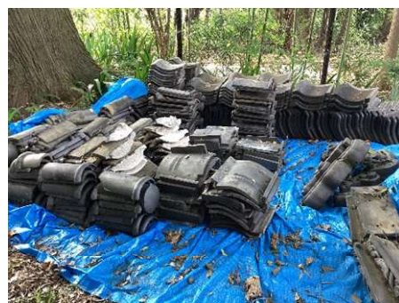
外した屋根瓦（再利用する）
