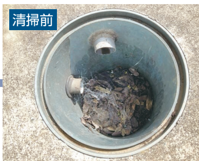
清掃前 砂利の間に土や落ち葉などが詰まっている状態
