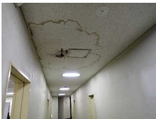
・建屋内部やバックネット支柱の劣化状況
