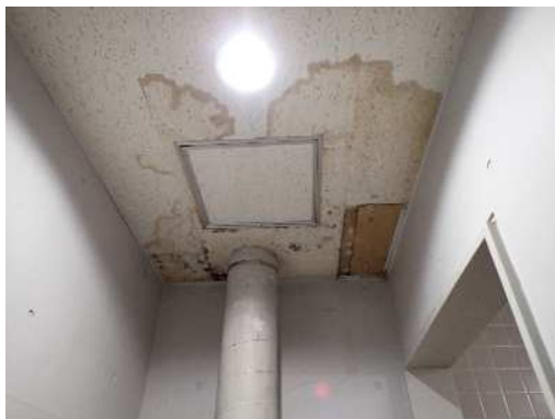
・内装の劣化がみられる箇所例（雨漏り・天井ボード脱落）
