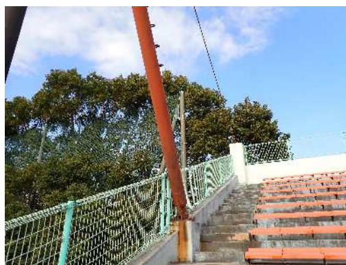
・建屋内部やバックネット支柱の劣化状況
