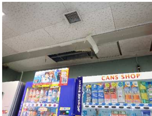
・内装の劣化がみられる箇所例（雨漏り・天井ボード脱落）
