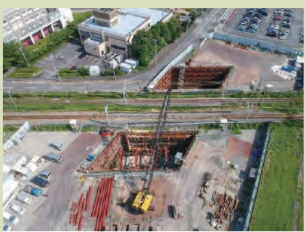
平成30(2018)年 鉄道の運行を継続したままトンネルを構築
