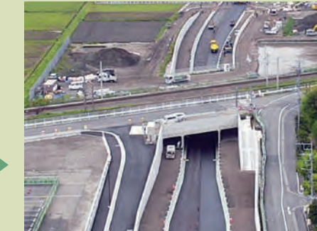
令和6(2024)年 舗装工事が完了。開通に向け、側道や交差点の工事を進める
