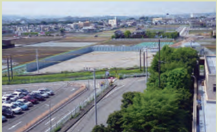
平成28(2016)年 アンダーパス部の工事に着手
