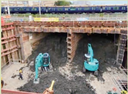
令和元(2019)年 鉄管を連結してトンネル部分が完成。地下を掘削
