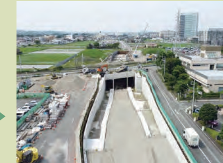
令和5(2023)年 コンクリートを敷き、車道と歩道を整備
