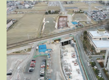
令和4(2022)年 アプローチ部の工が進む。トンネル前後にコンクリート壁を施工
