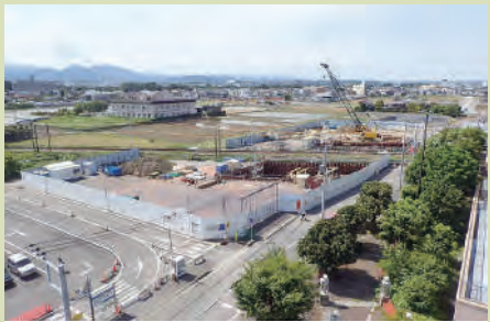
平成29(2017)年 線路前後を掘削
