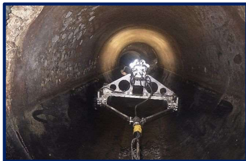
カメラによる管渠内の調査・点検
