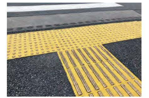
視覚障がい者が安全に移動するために設置された案内表示です。表面の突起を足の裏や白杖で確認して進みます。視力が低下している人も認識しやすくするため、路面の色などと色別しやすいとされる黄色で原則設置されています。
