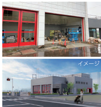
工事の様子(上)と建て替え後の南分署(下)
