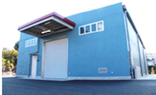
南部大型防災備蓄倉庫
