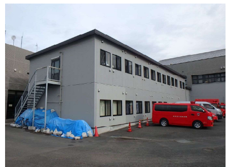
消防庁舎（増築棟）
