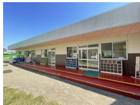
中新田保育園 増築棟①
