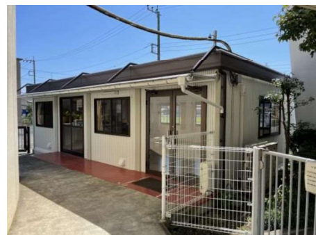
中新田保育園 増築棟②
