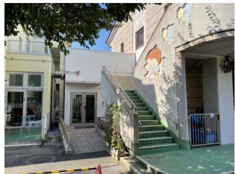
柏ヶ谷保育園 増築棟
