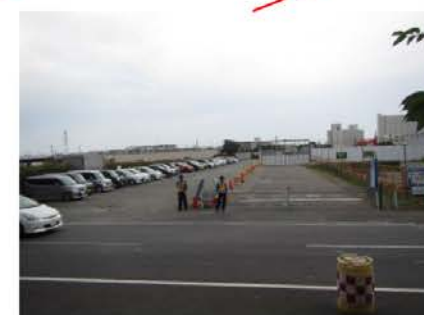
・工事中の(仮称)市道53号線バイパス (・アクセス、動線検討)
