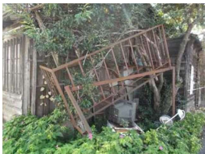
写真②：バルコニーの脱落
