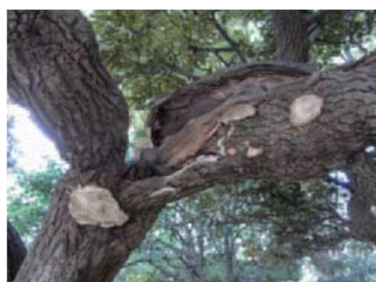
写真③：腐朽・空洞
