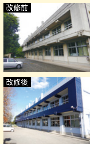
【老朽化した施設の改修例】 柏ヶ谷中学校外装
