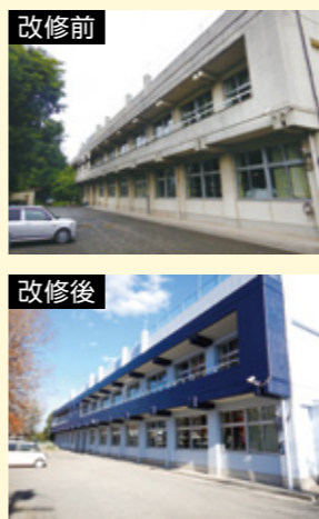
【老朽化した施設の改修例】 柏ヶ谷中学校外装
