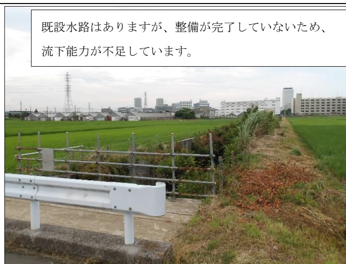
図 3.4-2 未整備水路の例（国分一号幹線）
