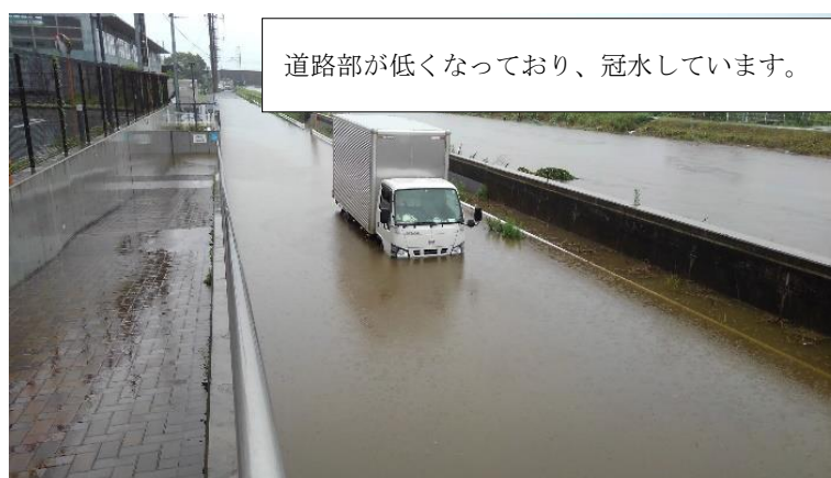
図 3.4-1 地形的要因による浸水箇所（本郷地内/令和3年7月1日～3日）
