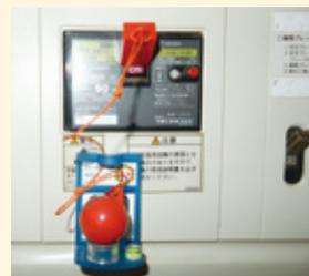
(例)設置工事不要の簡易型感震ブレーカー
