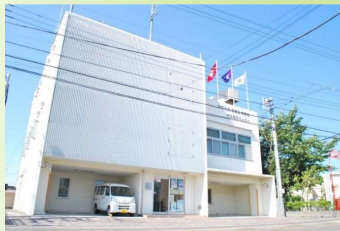
海老名市・座間市・綾瀬市消防指令センター
