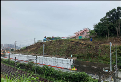
伐採施工中 令和6年7月
