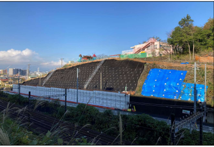
植生基材吹付工 令和6年11月
