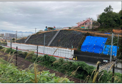
受圧板設置 令和6年10月
