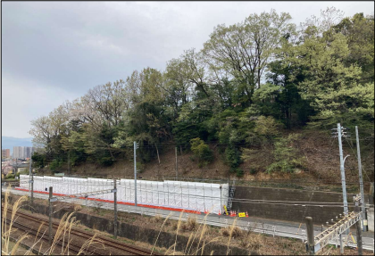
足場設置完了 令和6年4月
