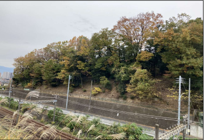
着工前 令和5年12月
