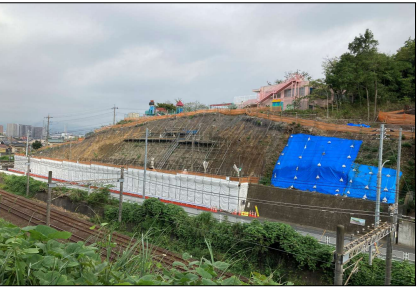
鉄筋挿入工 令和6年9月
