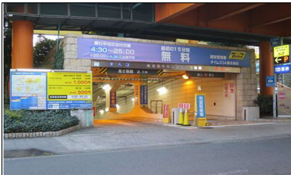
【海老名中央公園地下駐車場】
