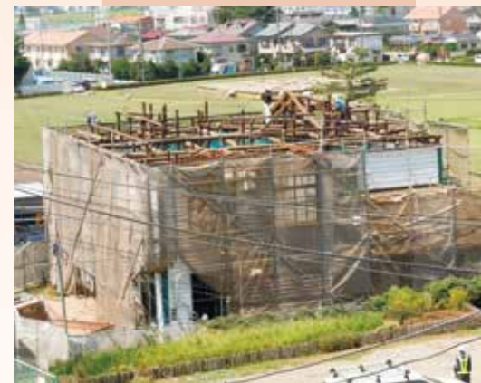
移築に向けた解体の様子(平成22(2010)年)
