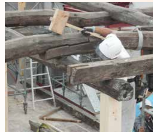
解体した部材を移築場所で組んでいる様子
