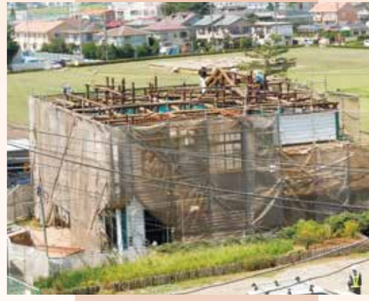
移築に向けた解体の様子(平成22(2010)年)
