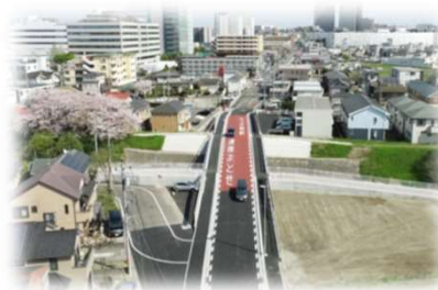
市道62号線延伸 ～郷ノ泉橋～
