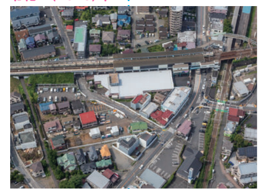
7月、既設建物の解体工事や道路、駅前広場などの工事に着手
