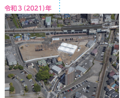
4月、起工式。住居棟、商業棟、駐車場棟の工事に着手
