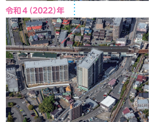
9月、住居棟が上棟。建築工事が最盛期を迎える
