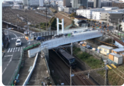
架設した横浜方面側の歩道橋
