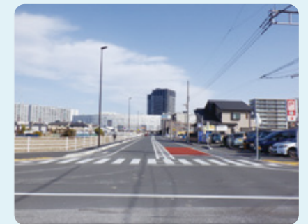
周辺道路の歩道も整備
