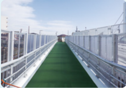
歩行者の安全性に配慮して手すりを設置
