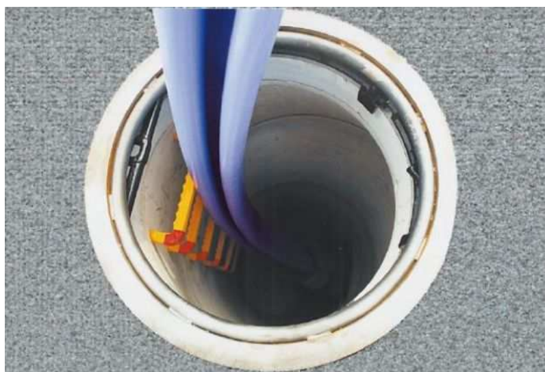
図 6.5 管更生工法_概略図
