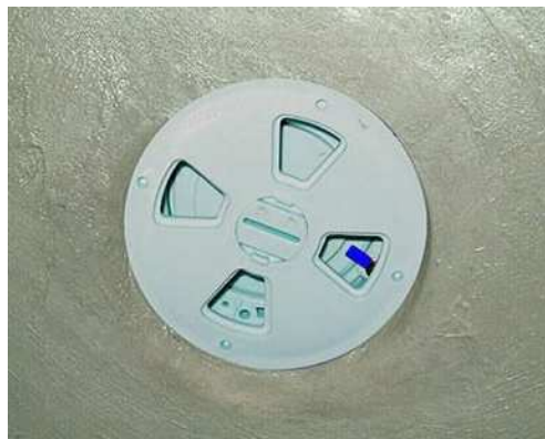
図 6.11 マンホール浮上防止対策例 (揚圧力 * 消散タイプ)
