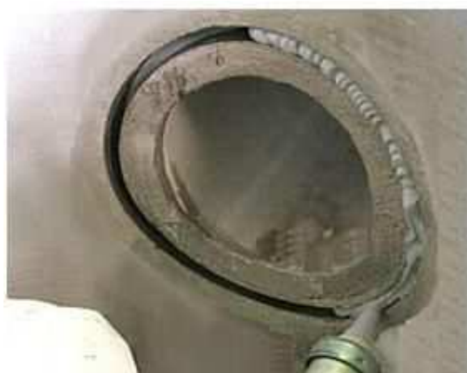
図 6.8 可とう性継手 ※ の施工写真
