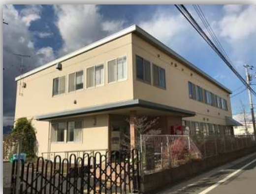
【海老名市障害者第一 デイサービスセンター】
