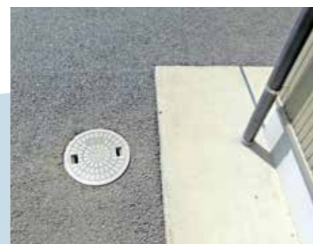
雨水浸透ますと雨どい
