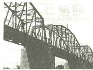
撤去直前の相模橋(厚木市提供)
