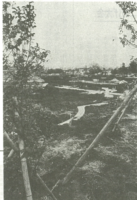
本格的な工事が始まった東柏ヶ谷近隣公園
