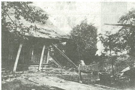
関東大地震で倒れかかった清水寺の水堂観音堂(左) (小島重治氏=大谷=が撮影)
