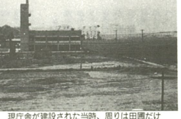
現庁舎が建設された当時、周りは田園だけ
