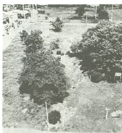
七重の塔の復元模型(左)と現在の塔跡(上)
