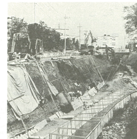
都市下水道の整備を推進 (写真は貫抜川親水護岸工事)
