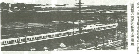
48年・海老名駅舎の移転のため建設が進む海老名駅周辺(上)。下は現在の海老名駅周辺の風景
