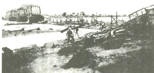
関東大地震後の相模橋 (宗住寺所蔵の写真)
