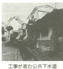
工事が進む公共下水道
