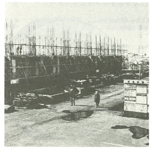
社会の運動公園となりに着工中の(仮)総合体育館
