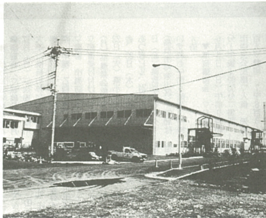
海老名工業団地協同組合九社が入居するアパート工場
