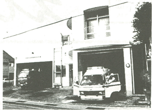
増改築工事が完了し救急車も配置された北分署
