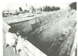
改修前の貫抜川
