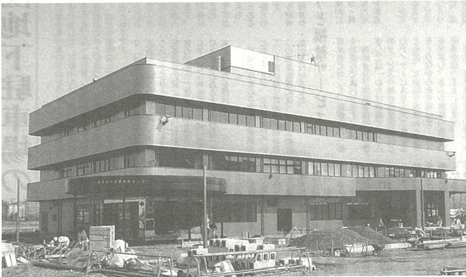
わかば会館の東隣りに建設された保健相談センター (3月13日撮影)
