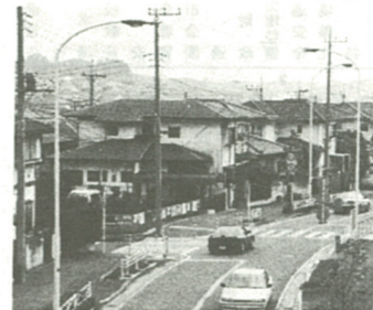
建築協定が実施されている浜田町
