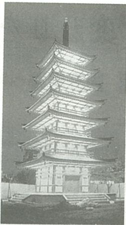
夜間照明を点灯した七重の塔
