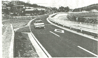
目久尻川沿いに開通した市道2196号線
