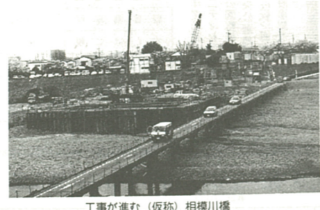
工事が進む(仮称)相模川橋
