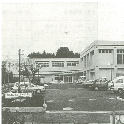
完成間近な杉久保コミュニティセンター(3月)
