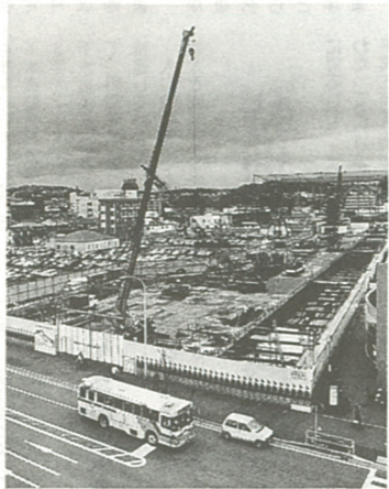
工事が進む(仮称)海老名中央公園地下駐車場
