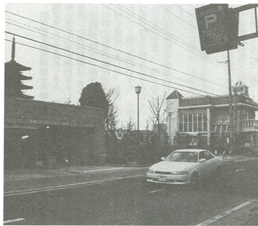
中央公園地下駐車場への出入口(市道18号線)
