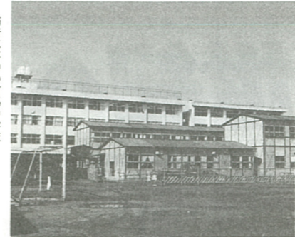
防音工事中の有馬中学校
