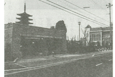
5月20日から利用開始の地下駐車場
