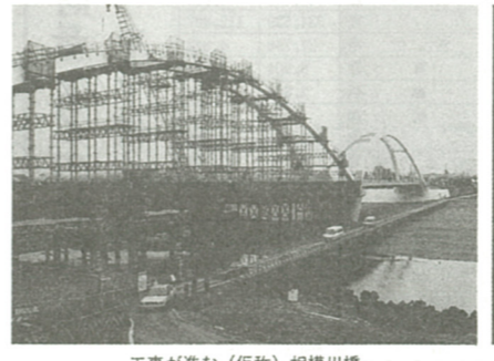
工事が進む(仮称)相模川橋
