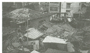
阪神大震災の被災地(1月21日撮影) ①職員の出動体制、指揮命令系統 ②救護物資受け入れ配送、生活必需品機材の確保 ③道路交通対策 ④ボランティア活用対策 ⑤災害弱者・医療対策 ⑥避難場所運営責任体制 ⑦仮設住宅建設 ⑧情報収集・伝達システム、広域協力体制 ⑨自主防災組織育成充実。 なお、阪神・淡路大震災による被災地に対する、市民の皆様への義援金の受け付けは4月17日で終了しましたが、その後お寄せいただいた7月10日現在で合計3千93万5千488円になりました。ありがとうございました。
